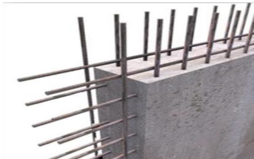
Figure 89 : voile en béton armé
