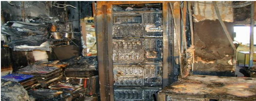
*Figure 1. 3.* Destruction du matériel par un feu électrique
