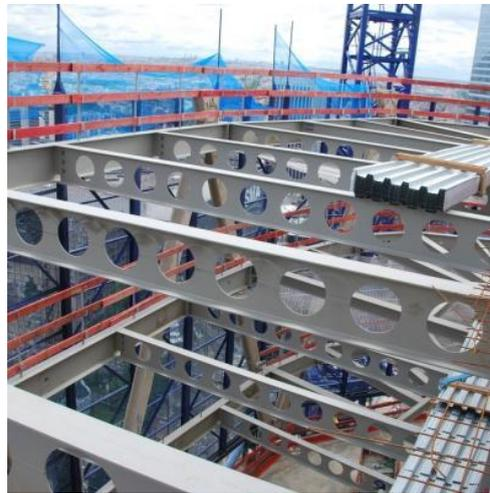
Figure 100 Des poutres en acier utilisées pour la structure du gratte-ciel
