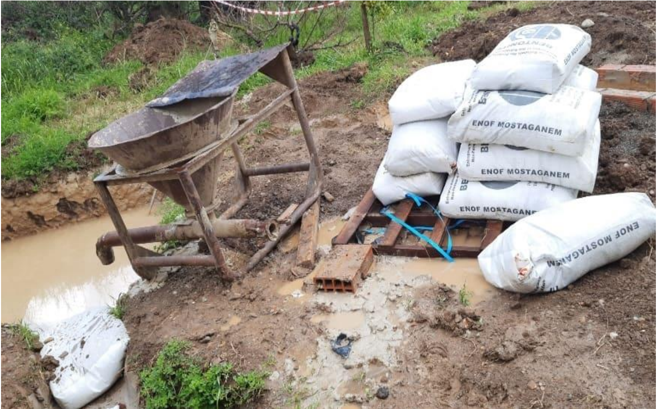
Figure 32 : préparation de la boue (bentonite)
