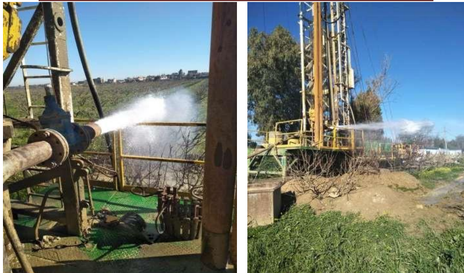
Figure 46 : développement a l'air lift
