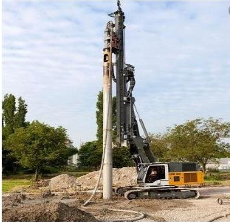
Figure 2 : forage par havage
