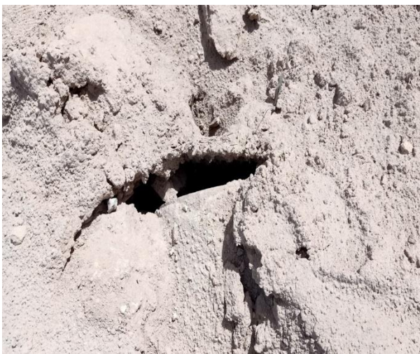
FigureIV.11: Conduites en mauvais état (SEHIRI.A, DAHMAN.A)
