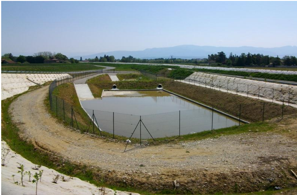
Photo I.1: Bassin de rétention
