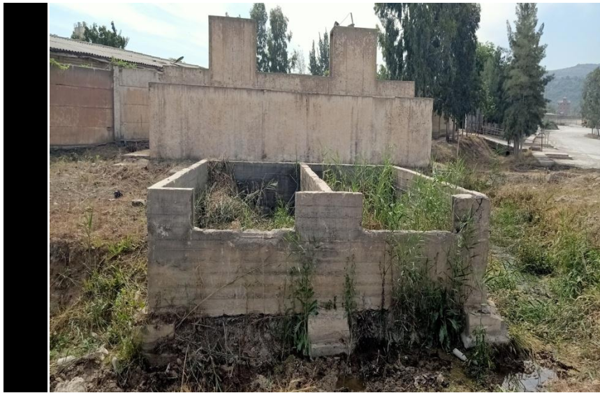
Photo IV. 5 : La station d'épuration (non opérationnelle) (SEHIRI.A, DAHMAN.A)
