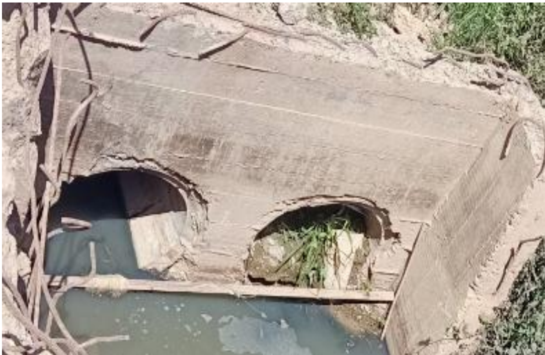
Photo IV.1: Canalisation enterrée (SEHIRI.A, DAHMAN.A)
