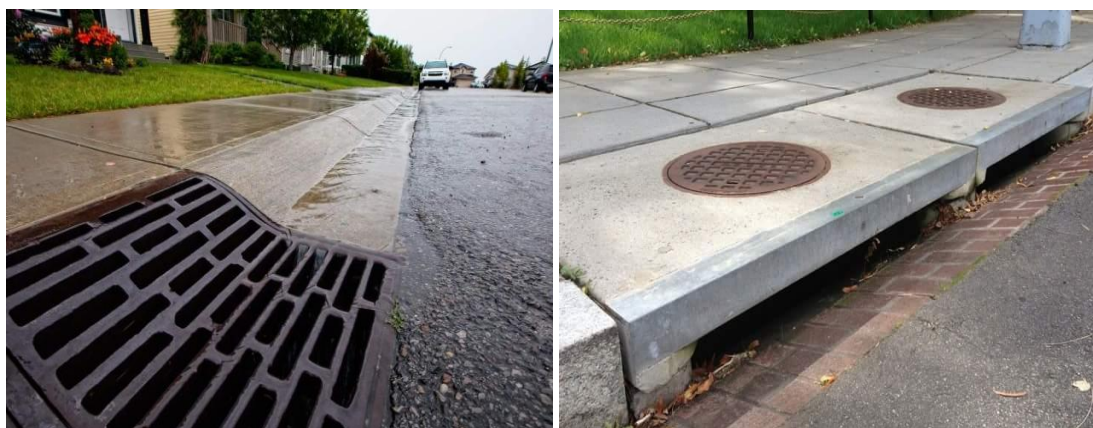
Photo I.2: Des bouches d'égout
