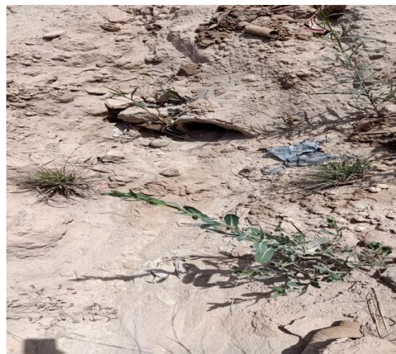
Figure IV. 12: Conduites en mauvais état (SEHIRI.A, DAHMAN.A)
