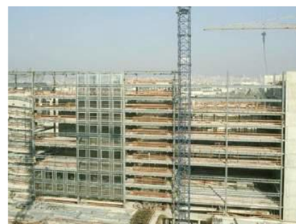
Figure 114: Photo d'une étape de construction montrant la structure.
