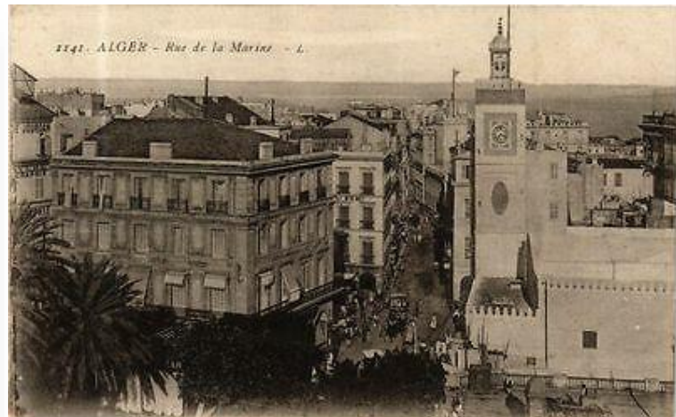
Figure 57: Ancienne vue sur l'axe structurant, La rue de la marine Source : Gallica.BNF.fr
