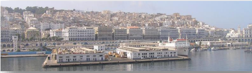
Figure 48: Paroi du boulevard de l'ALN Source : Google images
