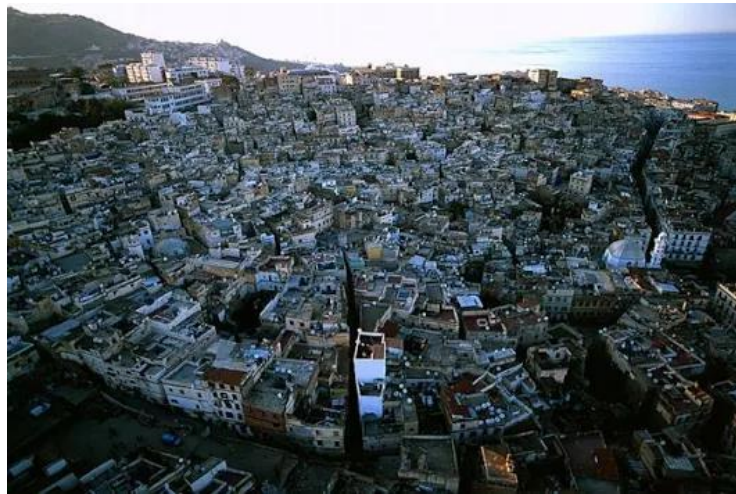
Figure 1 : Vue aérienne sur la casbah d'Alger. Source : Google images 2019
