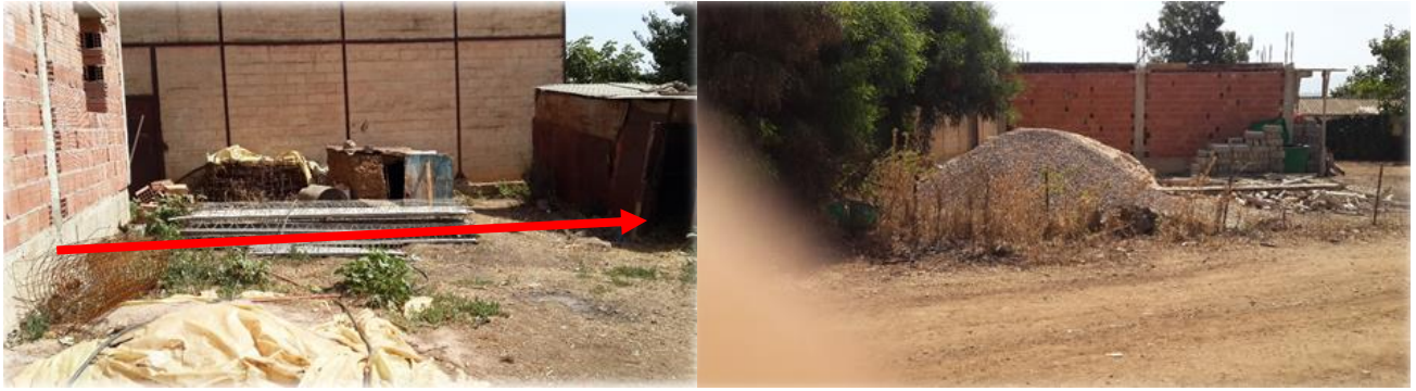
Photos II. 8 : collecteurs de collecte d'ordre Secondaire
