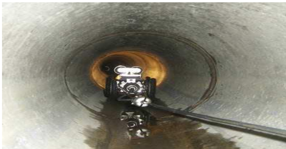
Figure IV. 1 : Photo d'une inspection télévisée, Source : [14]
