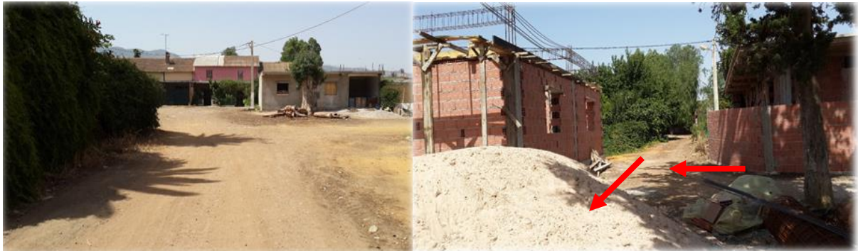
Photos II. 9 : Le Réseau d'assainissement Existant
