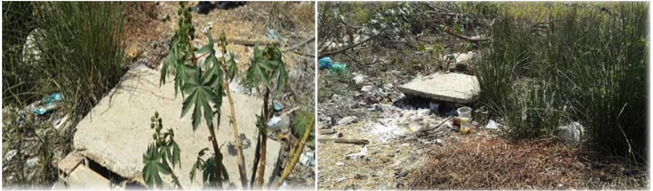
Photos II. 11 : Les Fosses septiques existantes
