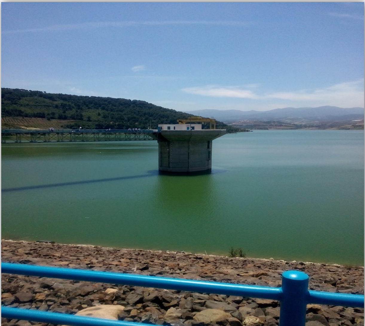
Figure 6: La tour de prise d'eau du barrage de Boukourdane (Photo, Mai 2017).
