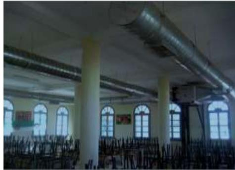
Cantine de l'école alimentée par climatisation géothermique.
