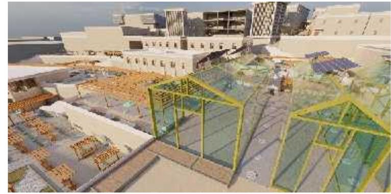
**Les techniques de construction :** La serre se caractérise par une trame structurale différente à celle du bâtiment à savoir une structure en bois
