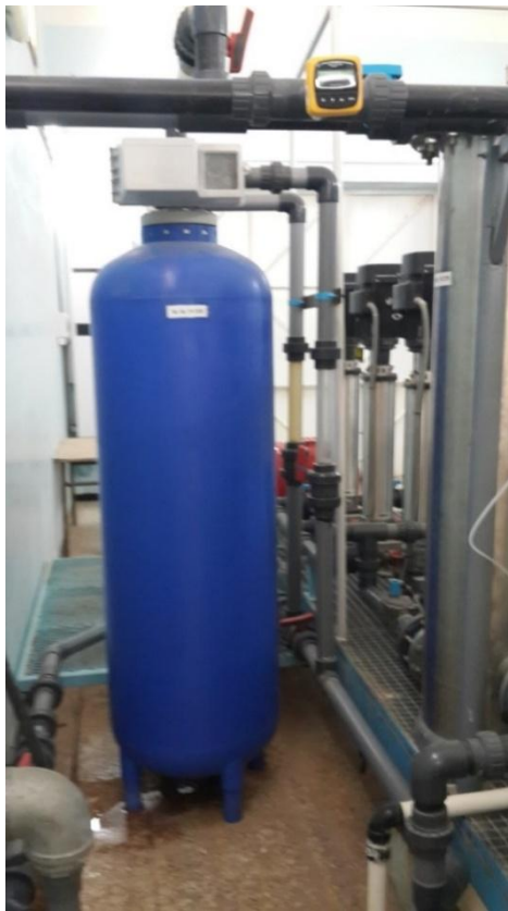
Figure II.1 : filtres à sables et anthracite
