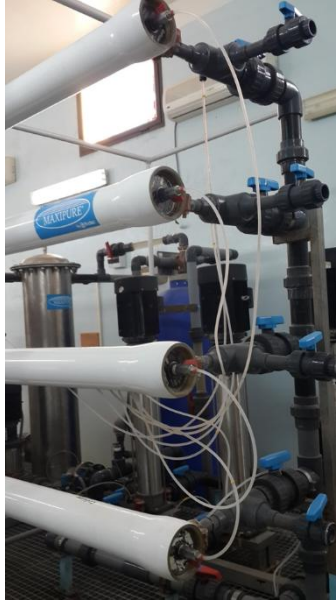
Figure II.3 : L'étape de l'osmose inverse
