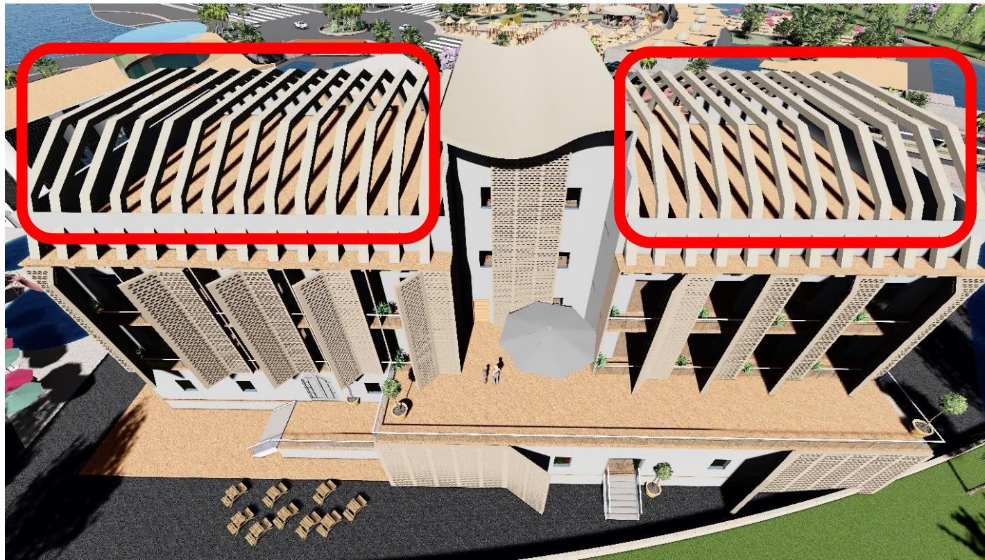
Figure : Utilisation de pergolas et les acrotères dans la terrasse de l'hôtel. Source : auteur 2020.
