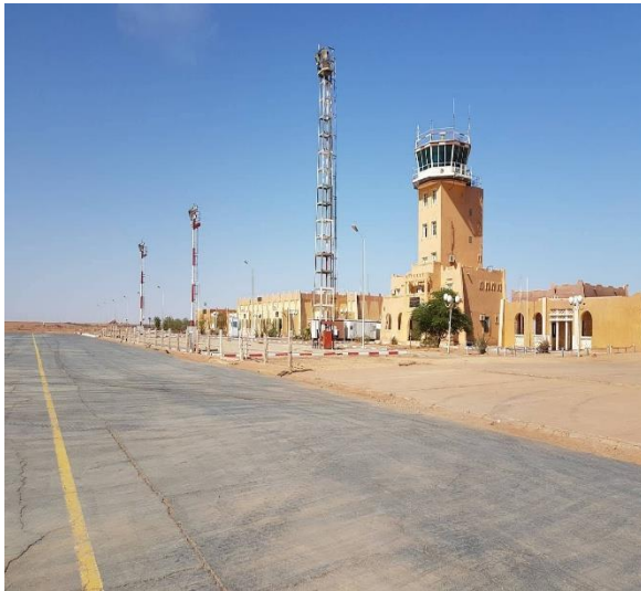
Figure 4.27 : Aéroport d'In Salah
