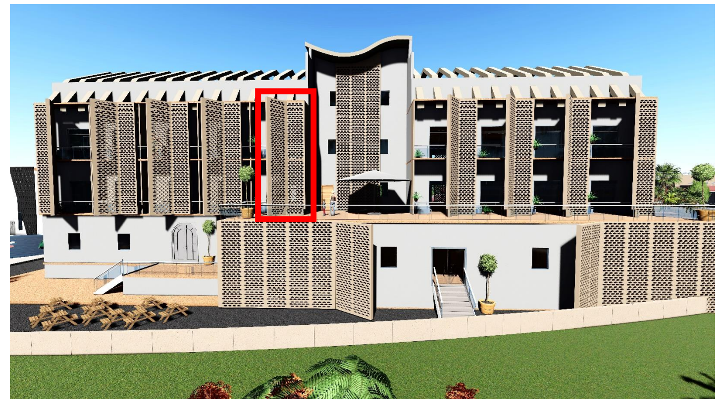
Figure : Utilisation des brises soleil avec un système de moucharabieh. Source : auteur 2020.
