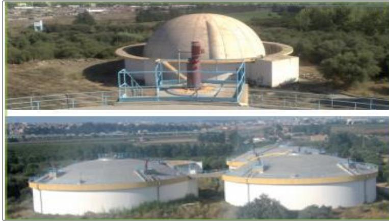
**Figure2.3** : Digesteur et Gazomètres de la STEP de Baraki (Alger) [40].
