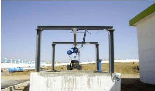
*Figure3.2* : Cuillère Bivalve au niveau de STEP de Tissemsilt.
