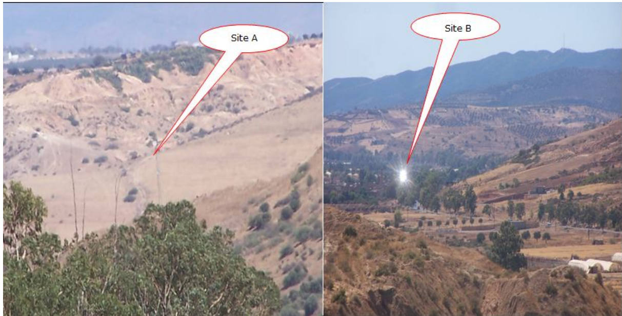
Figure 55 Vérification du LOS sur terrain effet miroir.
