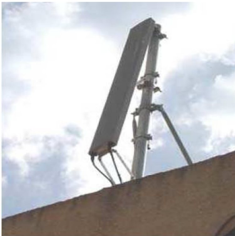
Figure 29 Antenne directionnelle avec Tilt positif.
