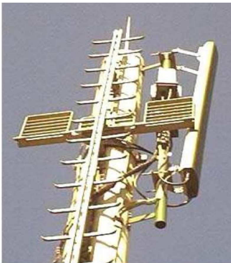
Figure 30 Antenne directionnelle avec Tilt négatif.
