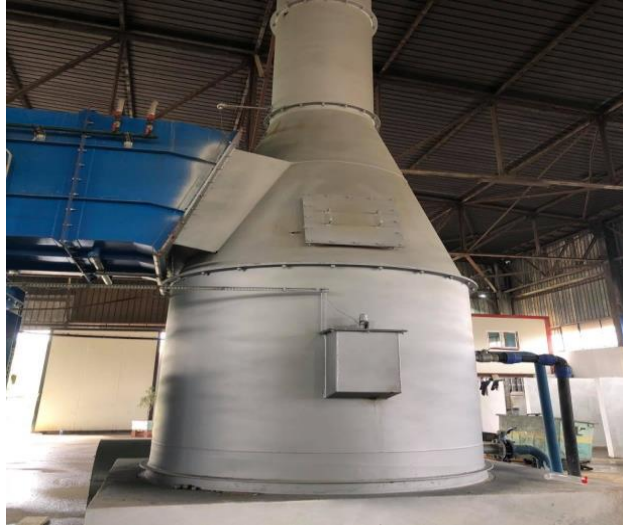
Figure III.6 : Cheminée de l'installation d'incinération
