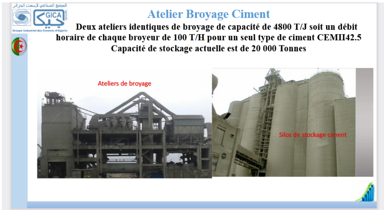
Figure I.19 : Photographie numérique montrant l'atelier du broyage de ciment
