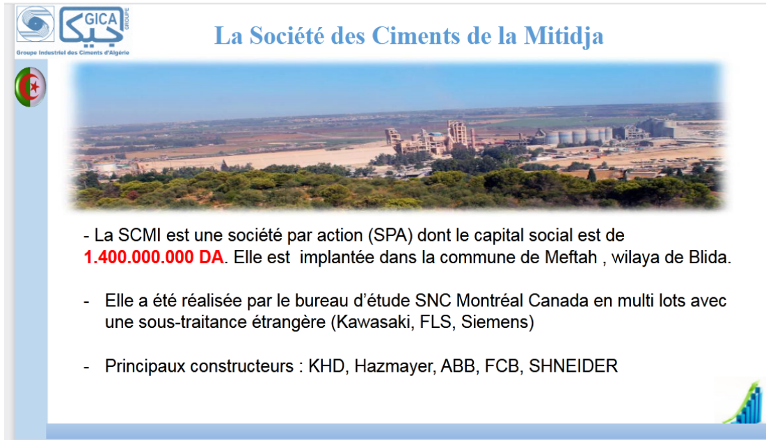
Figure I.2 : Photographie numérique montrant le site de la société des ciments de la Mitidja
