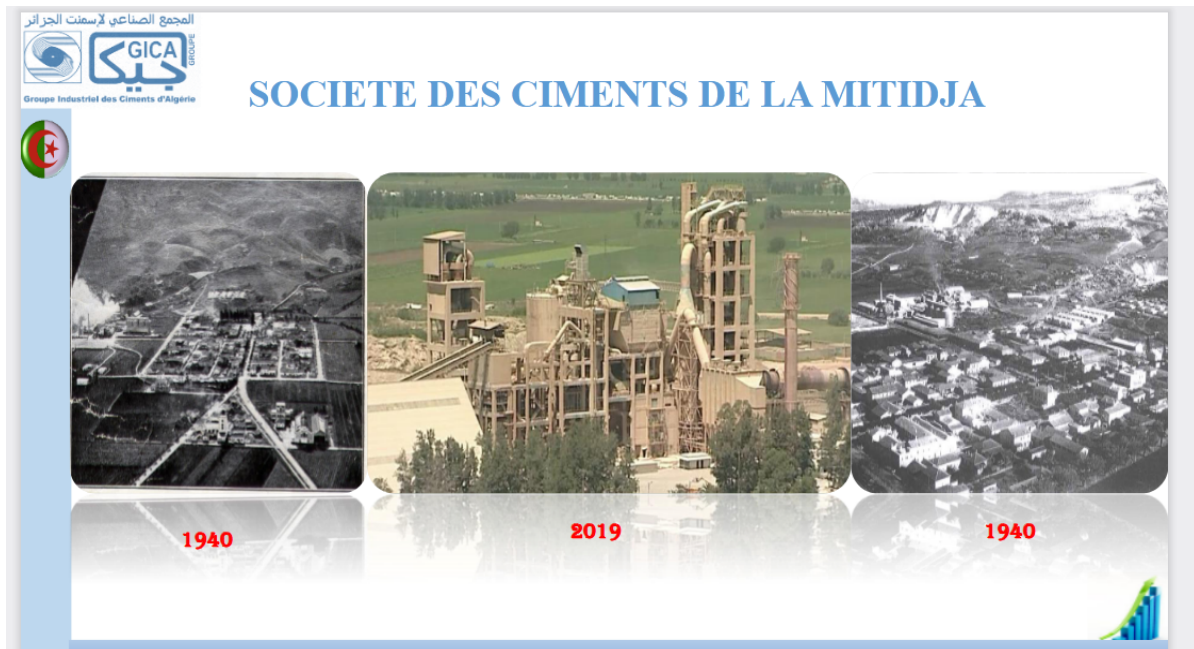
Figure I.1 : Photographies numériques montrant la société des ciments de la Mitidja
