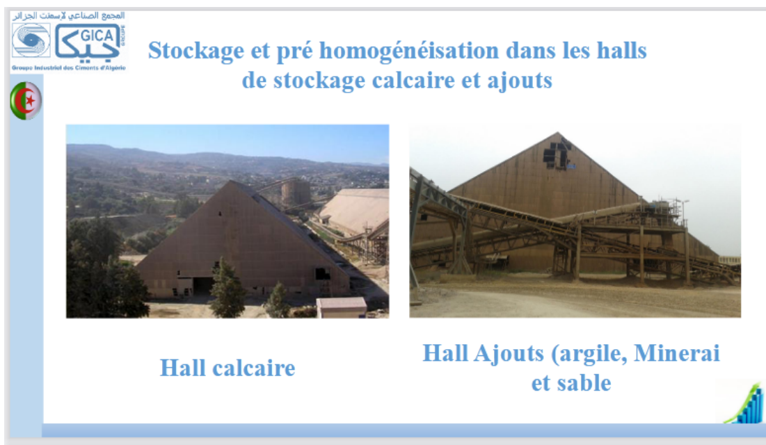
Figure I.7 : Photographies numériques montrant le stockage et le pré homogénéisation du calcaire et ajouts dans les halls de stockage
