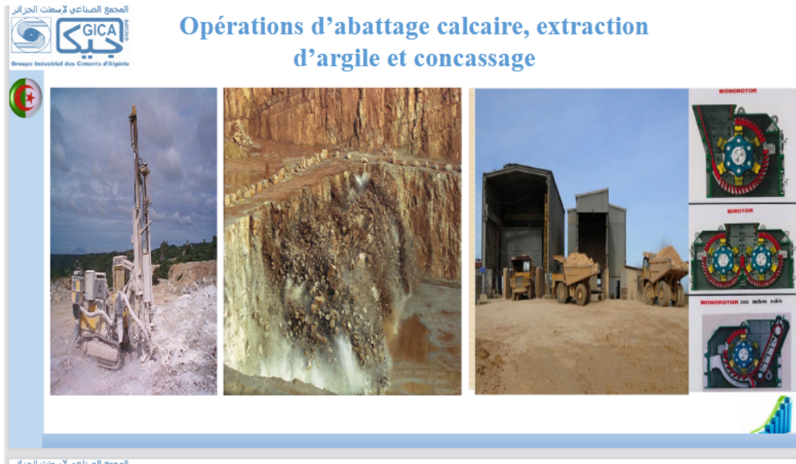
Figure I.6 : Photographie numériques montrant les opérations d'abattage calcaire extraction d'argile et concassage
