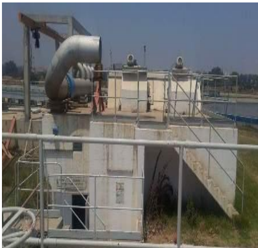
Figure 30 : Poste de recirculation et d'extraction des boues
