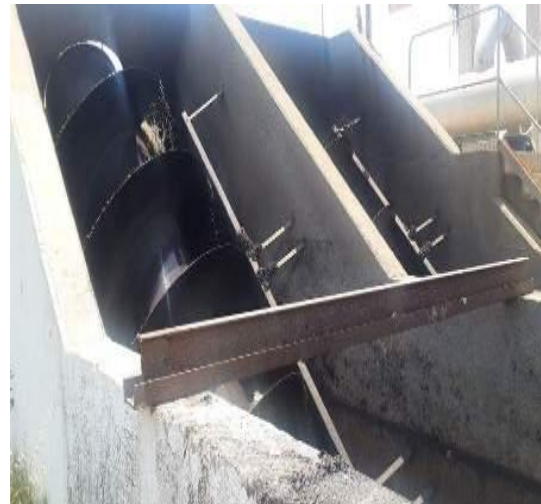
Figure 30 : Poste de recirculation et d'extraction des boues
