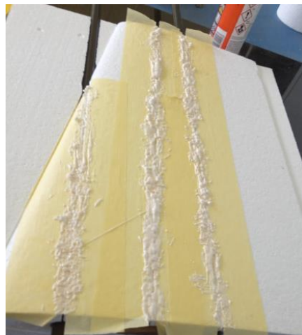
Préparation pour le remplissage des vides
