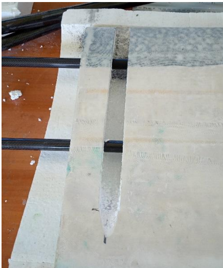
Traçage de l'emplacement des poutres
