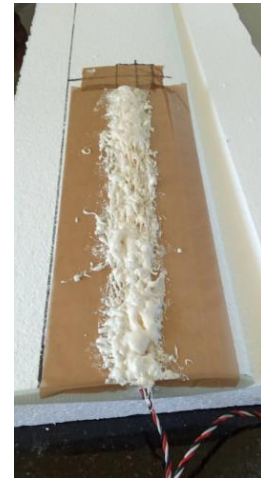
Revêtement du câble avec la mousse
