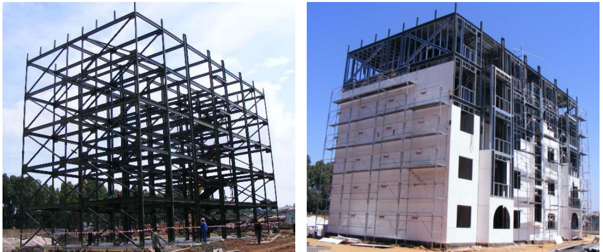
a) Ossature en profilés laminés à chaud
