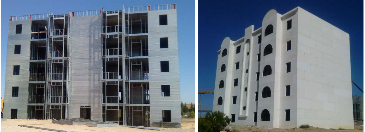
a) Bâtiment en phase de construction
