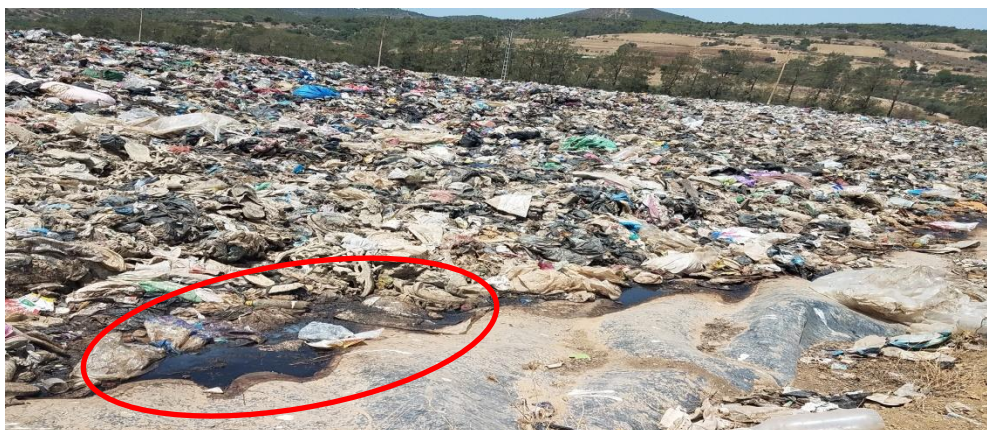
Figure 2.22 : stagnation des lixiviat sur les bords du casier
