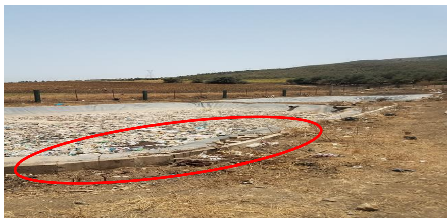
Figure 2.27 : bordure en béton autour des bassins
