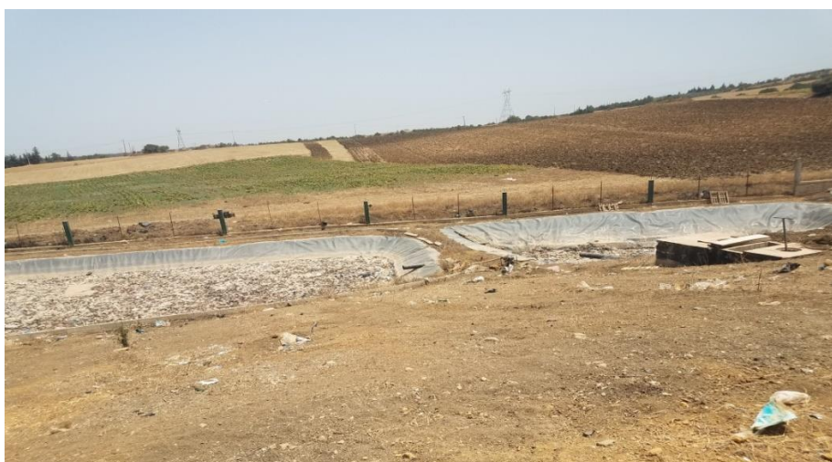
Figure 2.26 : bassins de rétentions des lixiviats
