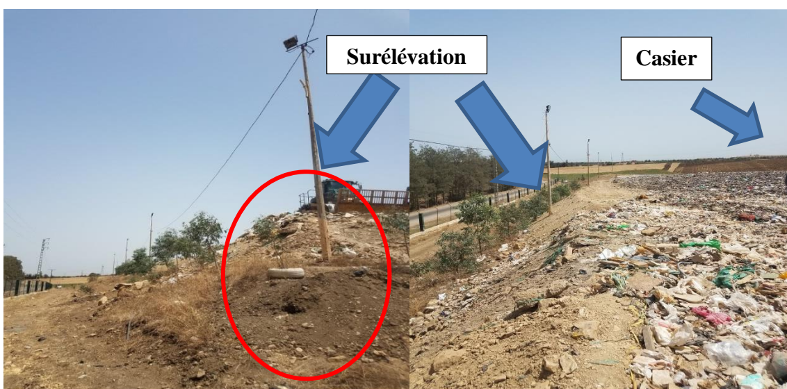
Figure 2.18 : Surélévation réalisée par l'exploitant
