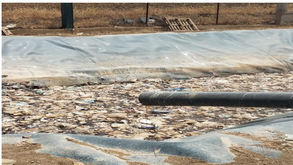
Figure 2.29 : Bassin de rétention des lixiviats
