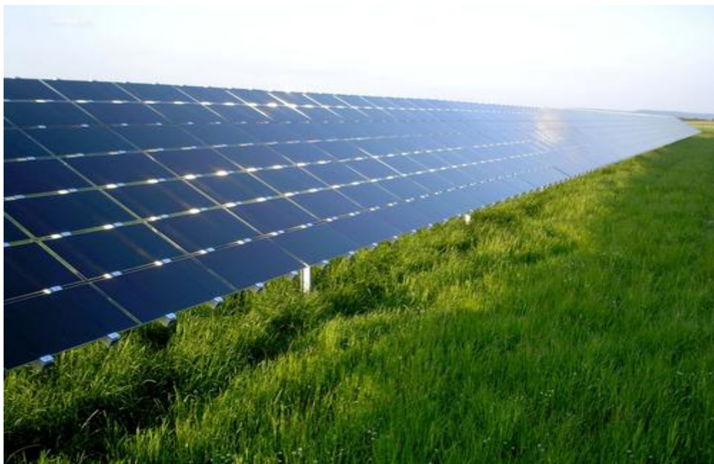
Figure 2.14 : Panneau photovoltaïque en tellure de cadmium [41].
