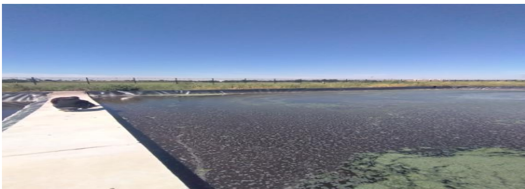
Figure 2.1 : Bassin de lixiviats au niveau de la décharge d'Oued Smar.
