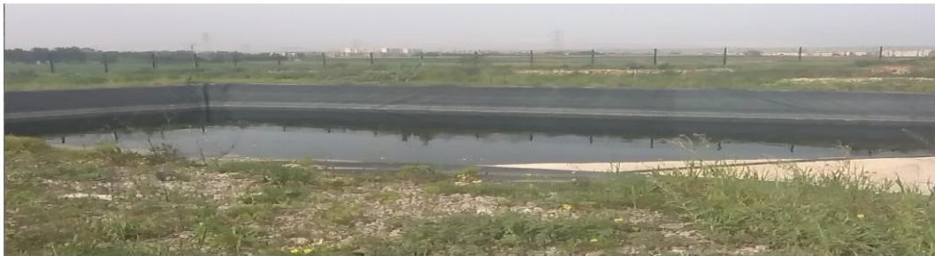
Figure 1.6 : Bassin de lixiviats d'une décharge.
