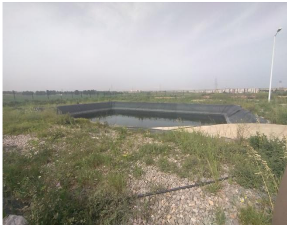
Figure 1.2 : Bassin de lixiviats.
