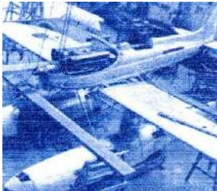
**Fig (1- 05) :** 1931 : le Super\_marine S 6-B reçoit son moteur Roll.-Royce R
