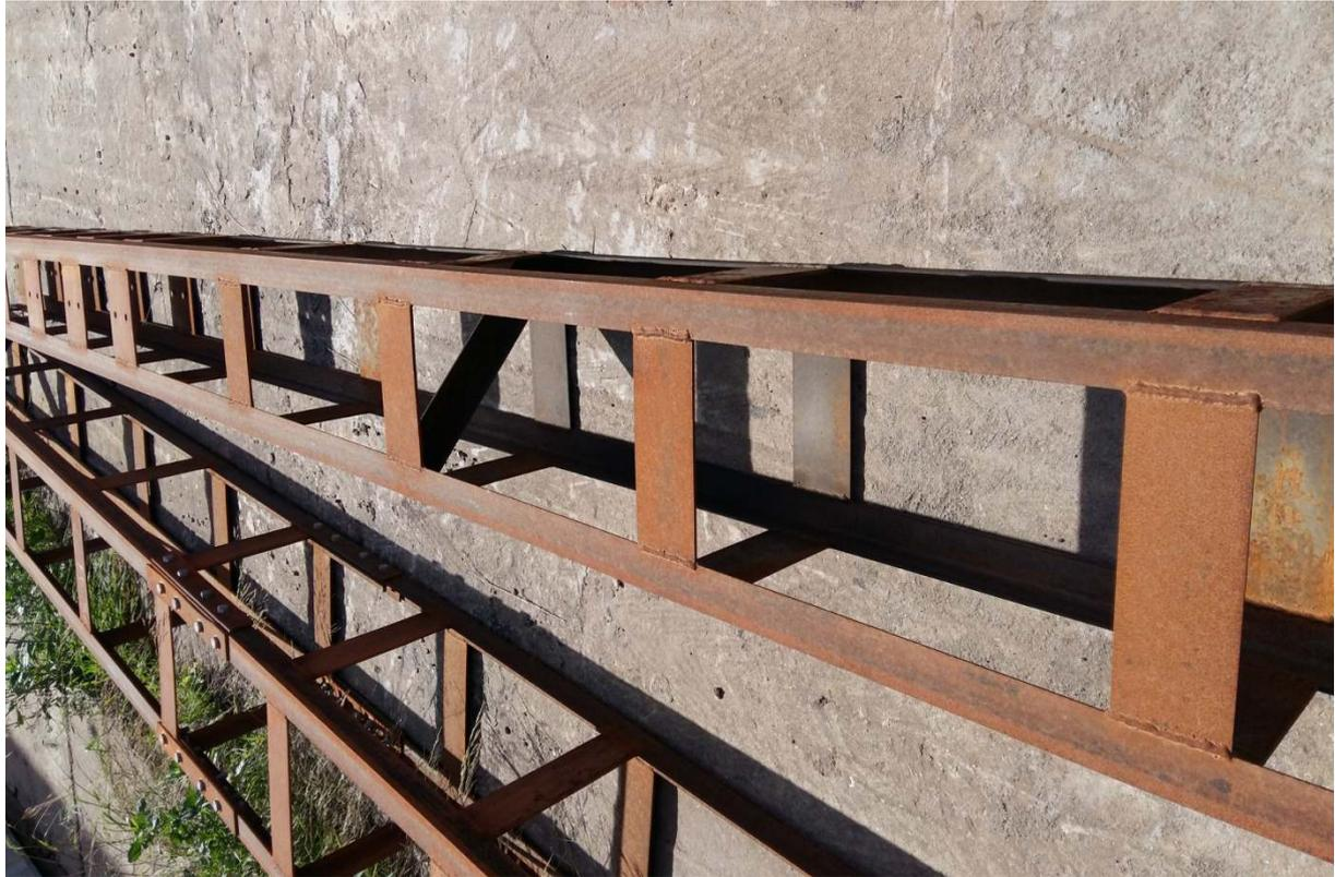
**Figure I-1** : Poteaux métalliques type HTA.BT.
