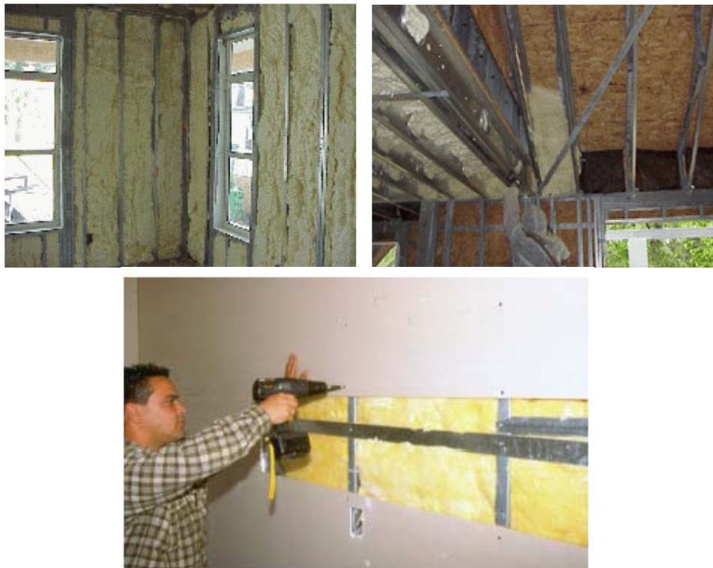
Figure 1.10 : Introduction des la mousse isolante entre les panneaux de murs et plancher pour l'isolation thermique et phonique.
