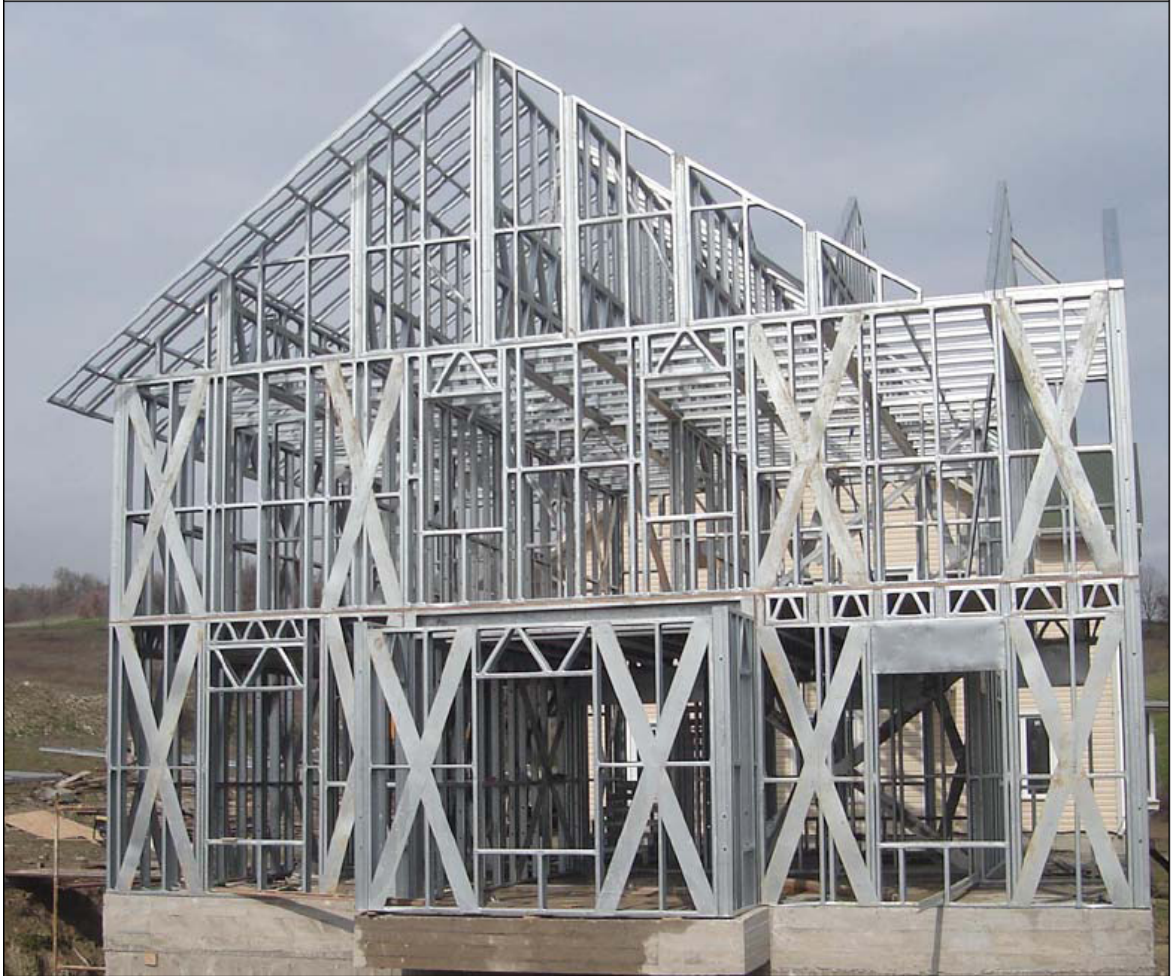
Figure 3.3 : Contreventement en X d'une structure en PAF.
