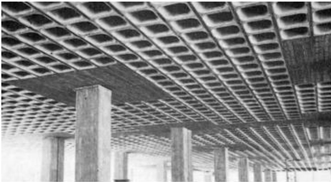
Figure III.5 panneaux de dalle du poteau
