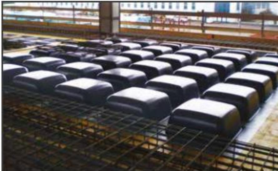
Les étapes suivantes seront le bétonnage puis le décoffrage qui, avec les caisses en plastique se fait aisément en dévissant un simple boulon de fixation et laisser descendre celui-ci sans causer de dommages sur le béton et éviter ainsi les fissuration de celui-ci.
