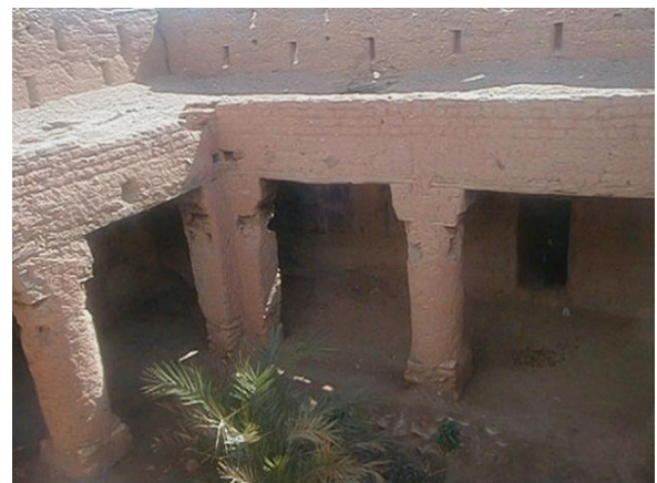
Fig 1.10 : Maison à deux piliers au ksar de Kenadsa (J. Bachminski et D. Grandet, 1985)
