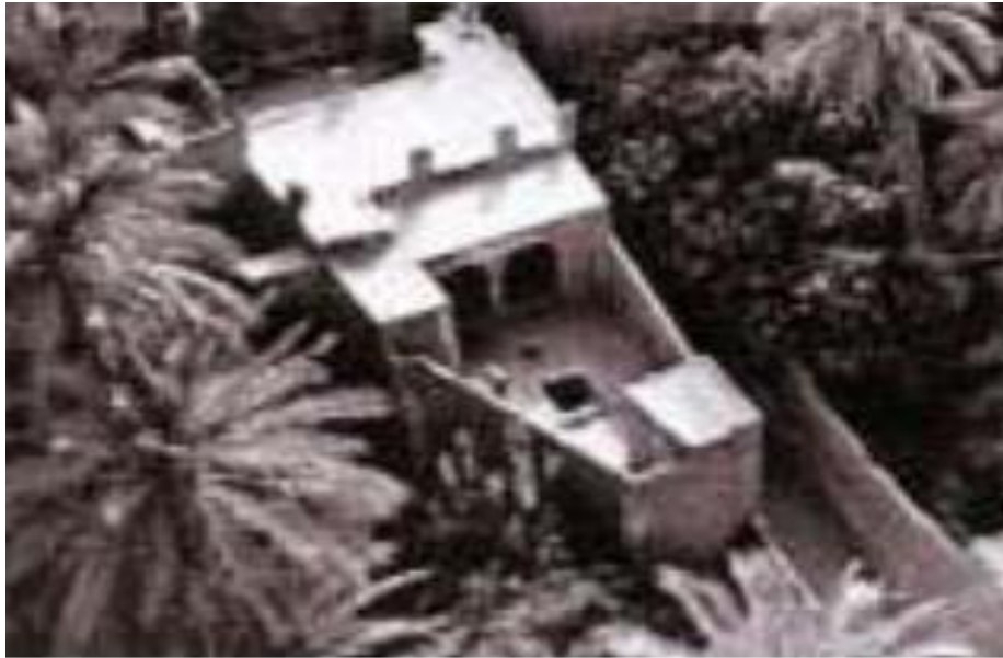
Fig 2.24: Habitat cour, Maison de la palmeraie à Ghardaïa. Source : CORPUS, Architecture traditionnelle méditerranéenne
