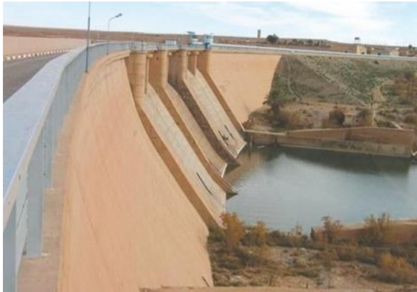
Fig 4.22: Barrage Djorfitorba, eaux souterrais à Bechar
