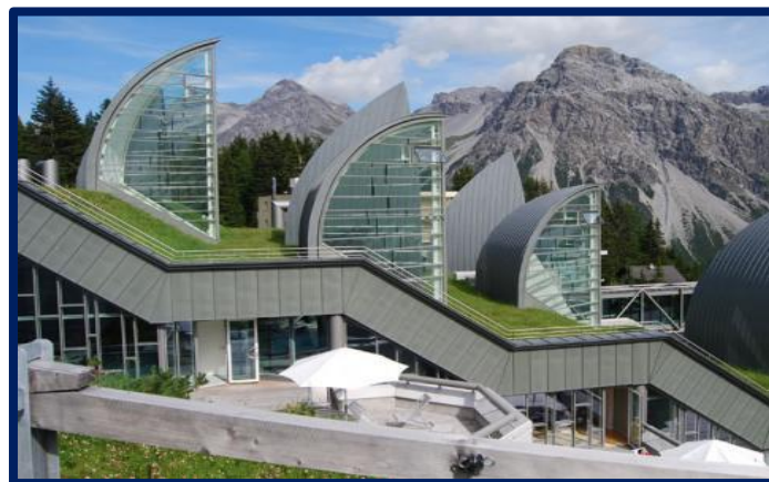
Fig3.10: Façade est de TschuggenBergoase
