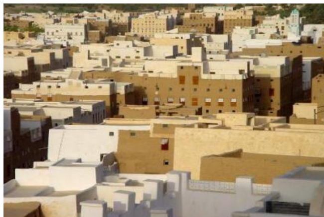
Fig 2.26: Vue sur les toitures terrasses de Shibam au Yémen. Source :
