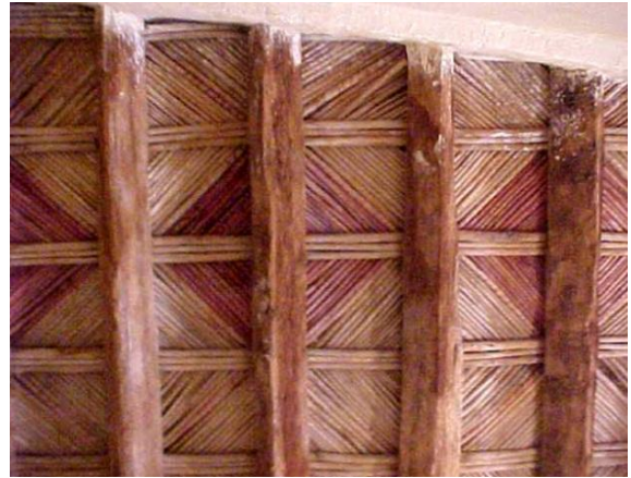
Fig 1.15 lattis serré de tiges de roseau à Juxtaposées à Taghit (2003) à Boussemgoun (2003)
