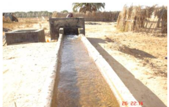
Photo 2.2 : Canal d'irrigation en béton dans la zone de Sidi Slimane en 2008.
