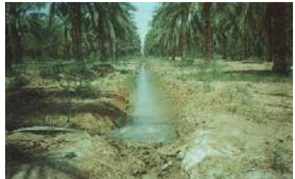
Photo 2.1 : canal d'amenée en terre "Seguia" dans la zone de Sidi Slimane en 2008.
