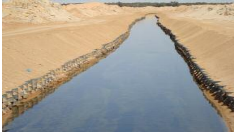
Photo 2.9 : Protection du canal de l'Oued Righ contre l'érosion des berges dans la zone de Ranou en 2009.
