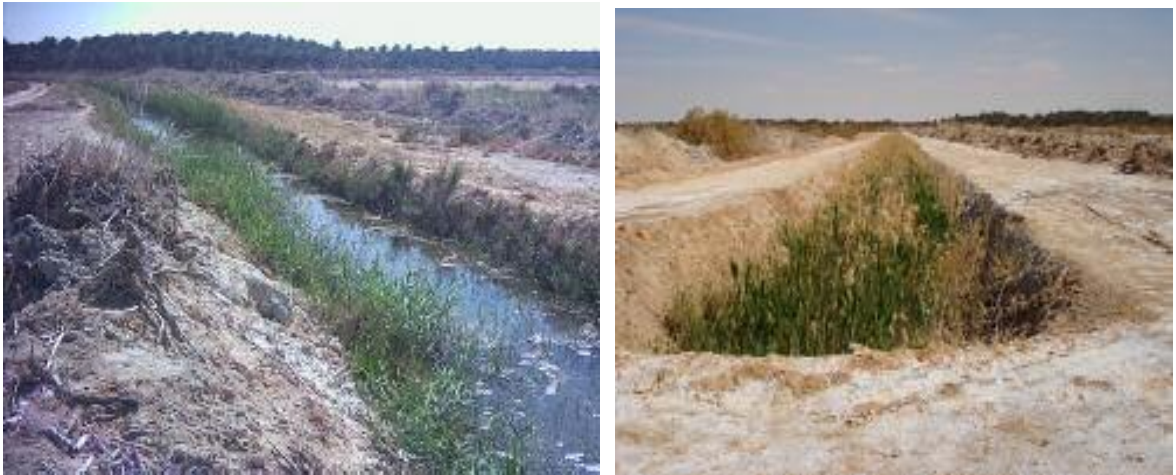
Photos 2.7 : Drains secondaires colmatés et envahis par les mauvaises herbes "Roseaux" crée des risques d'excès de sels et des eaux (stagnation) en 2008.
