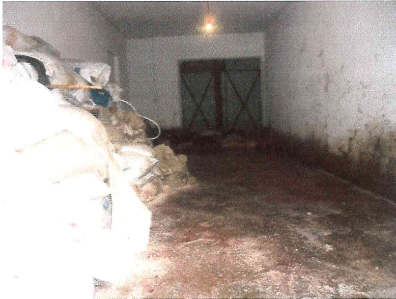
Photo(OrgII.4) : Chambre de salage et stockage des peaux.
