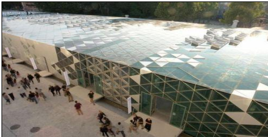
Figure 16: Panneaux solaire permettant l'économie de l'énergie et de les intégrer dans l'esthétique architecturale. Source : https://www.archilovers.com Consulté le 25.06.2018
