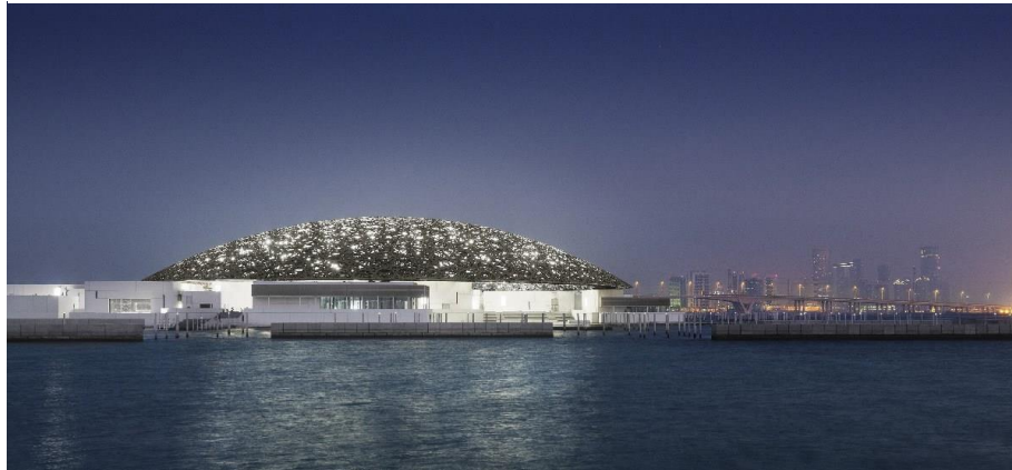
Figure 14: Mise en lumière extérieure du dôme du musée du Louvre Abu Dhabi. Source : https://www.lightzoomlumiere.fr Consulté le 10.06.2018
