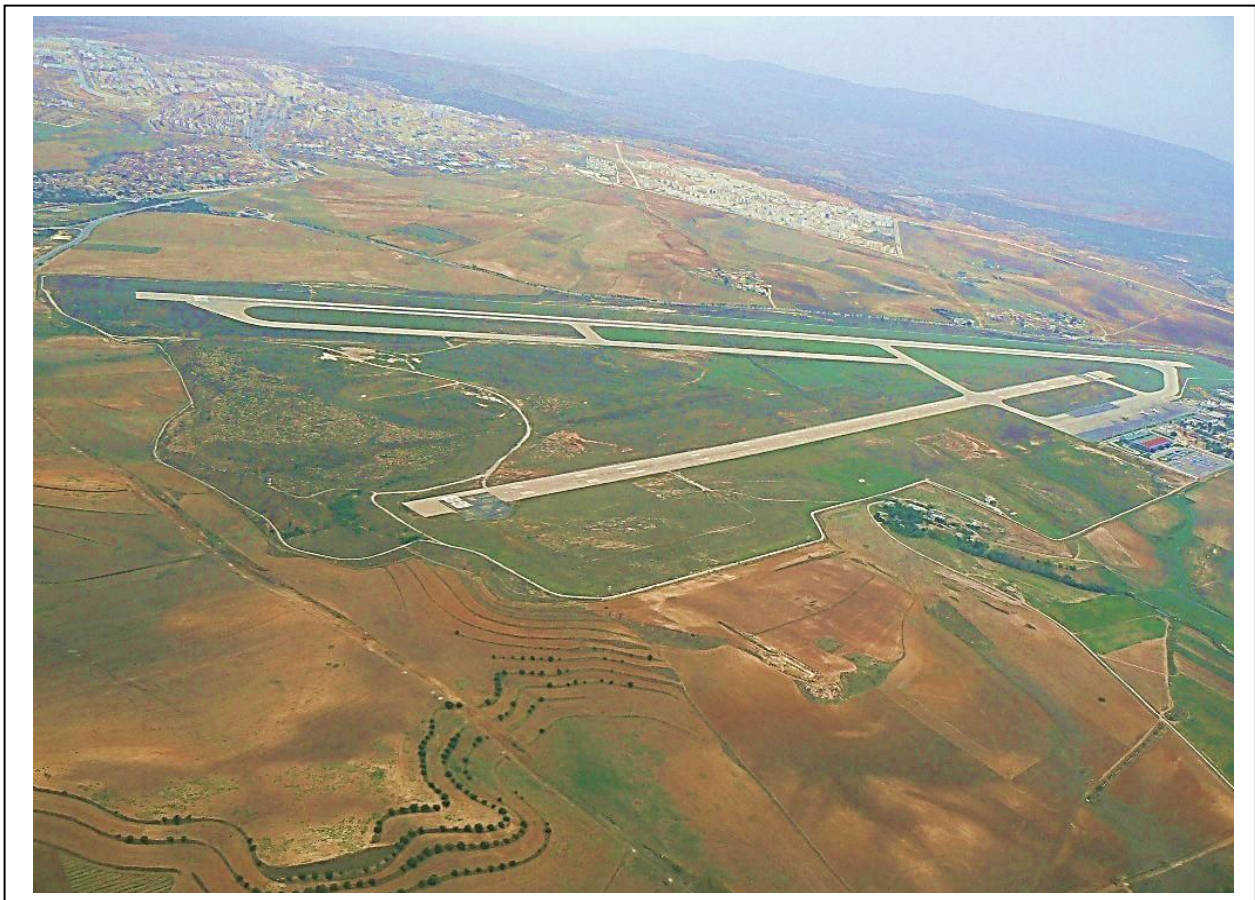
Figure 3-5: Vue de l'aérodrome de Constantine.
