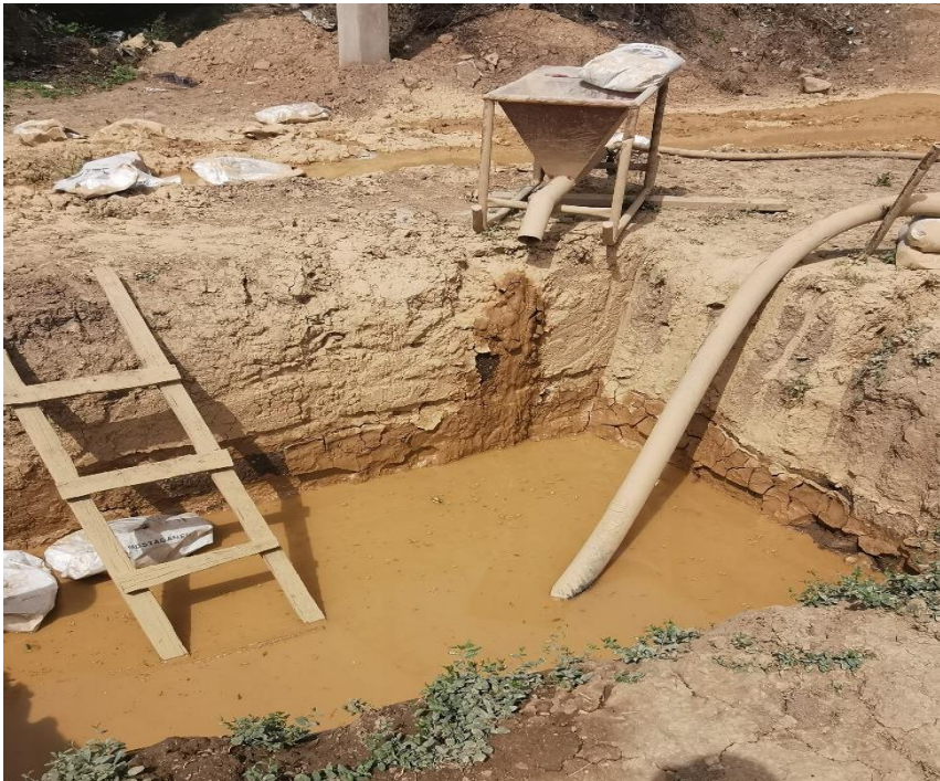
Figure 26 : Bassin de preparation de La bentonite.
