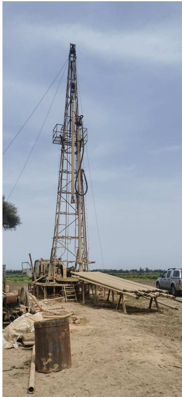
Figure 25 : Appareil de forage.
