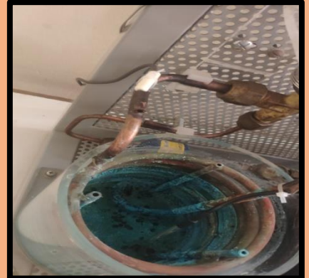
3- montage sur le banc
