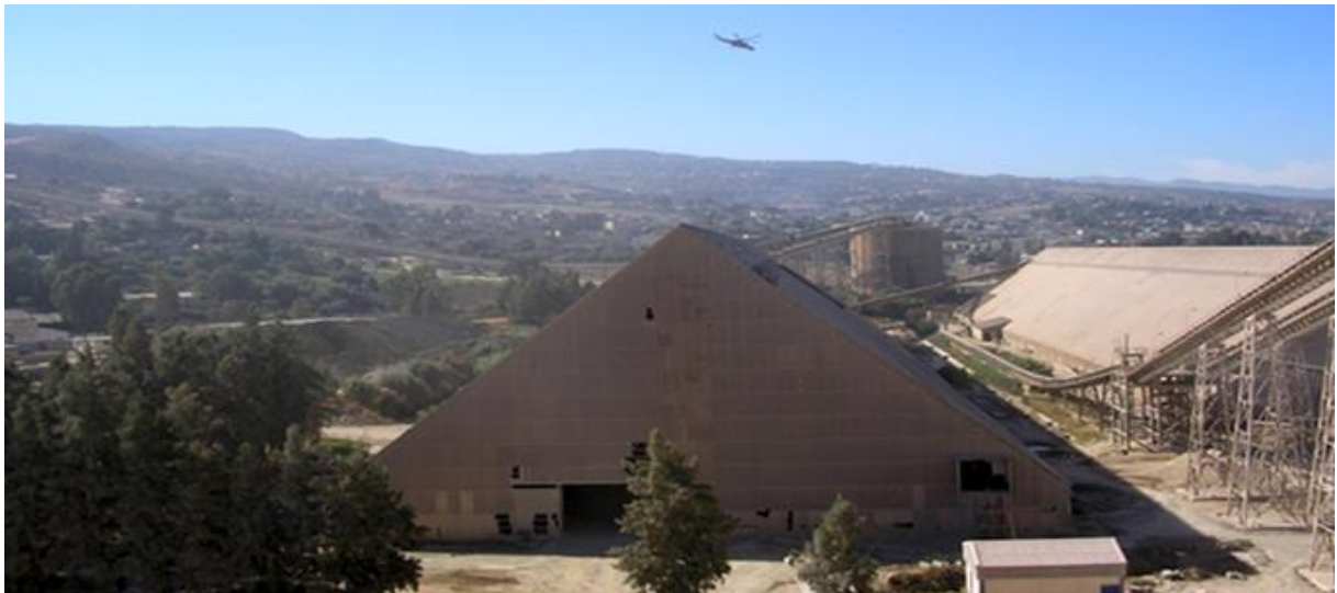
Figure 1.4. Salle de pré homogénéisation.
