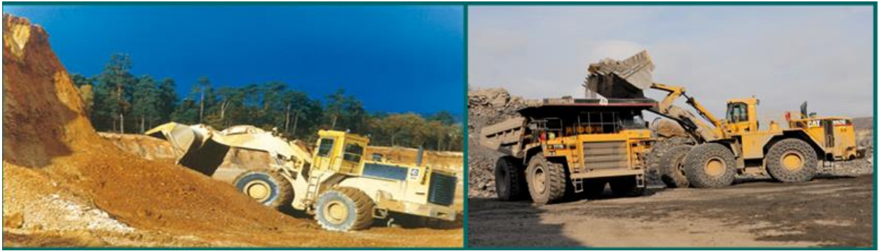
Figure 1.1. L'extraction de la matière première.
