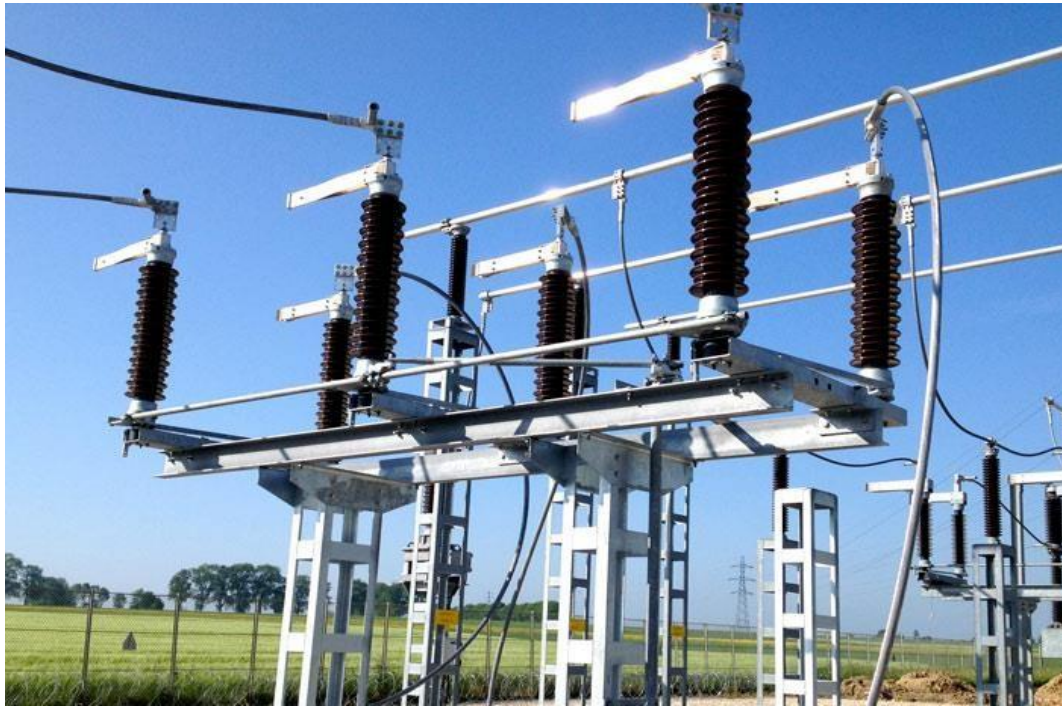
Figure 1. 15 : Sectionneur haute tension
