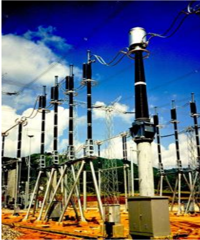
Figure 1. 9: Disjoncteur à haute tension
