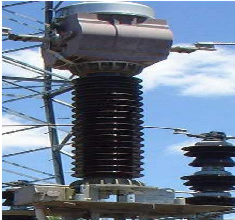
**Figure 4.17** : Transformateur de courant
