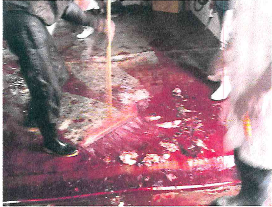
Figure N°6 : Accumulation par absence de Pente.
