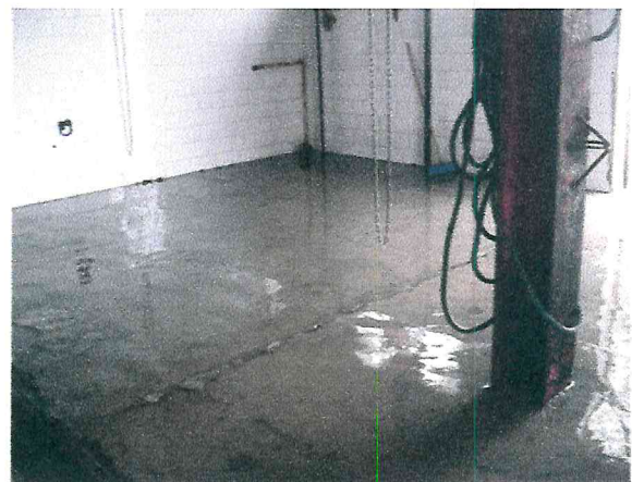
Figure N°4 : Sol lisse au niveau de hall d'abattage/habillage.
