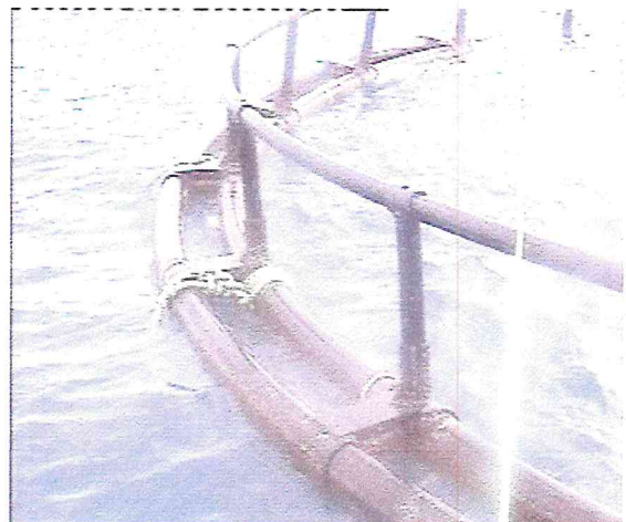
Figure N° 20 : Structure superficielle d'une cage flottante
