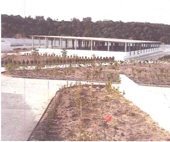
Figure N° 06 : Bloc de bassin couvert
