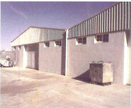
Figure N° 10 : Hangar du stockage et Atelier de la maintenance
