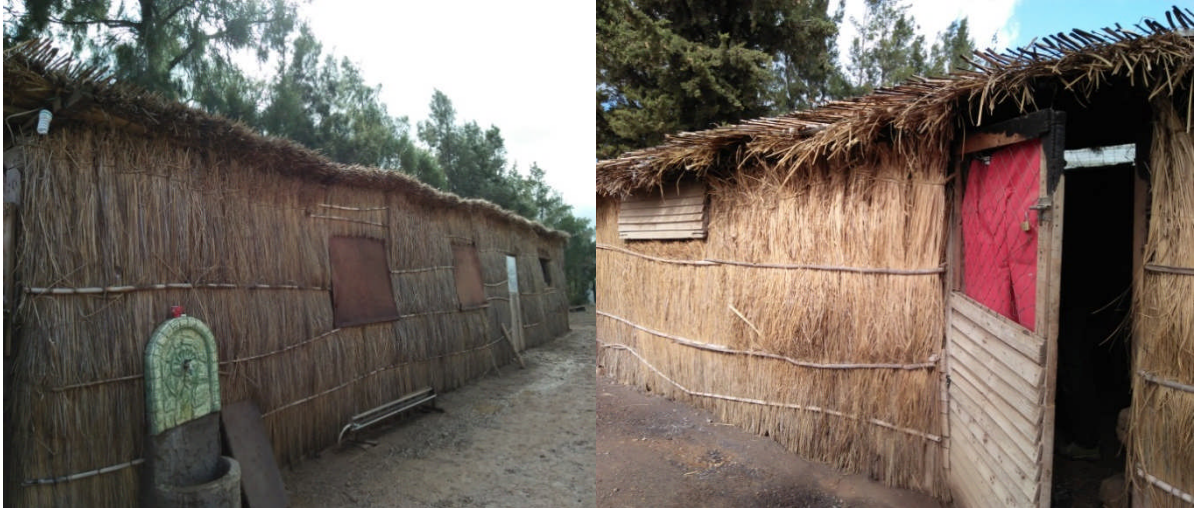
Figures 8 : 1-2-1 le bâtiment d'élevage
