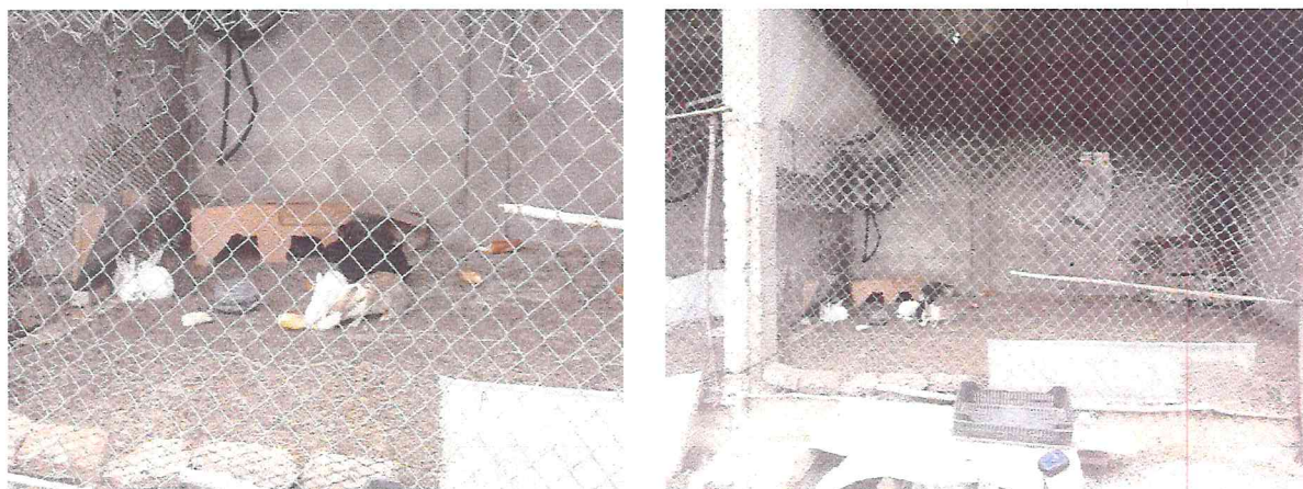
Figure 12 : Bâtiment en ciment Région de Tablate
