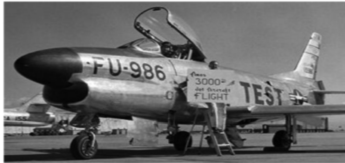
Figure I.11 F-86D nord-américain avec prise d'air ventrale (image NASA).
