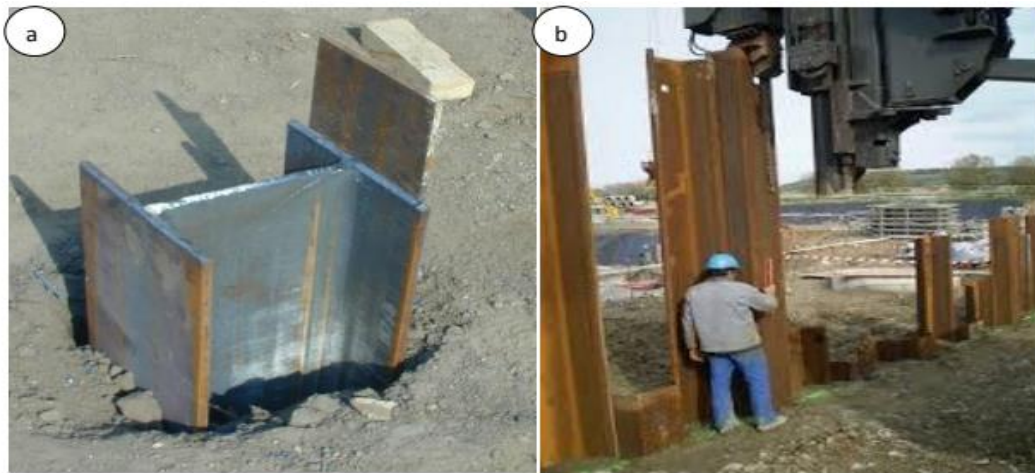
Figure 1.5 : (a : Pieux en acier -b : en profilé H ou I, c) : palplanche.
