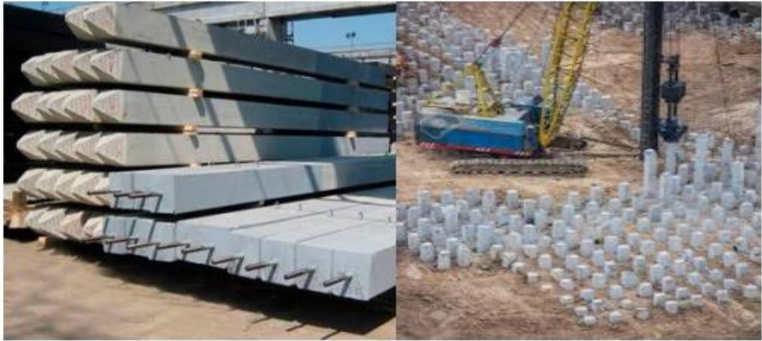
Figure 1.4 : Pieux en béton armé [16].
