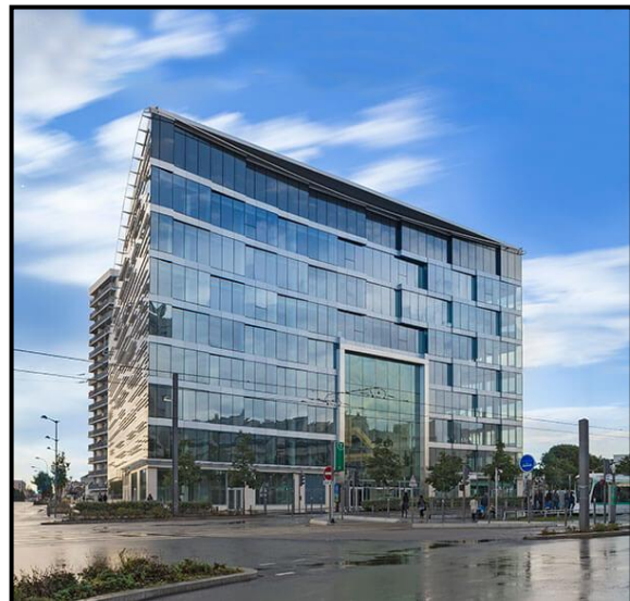
Figure 11 : L'immeuble de bureau SCENEO
