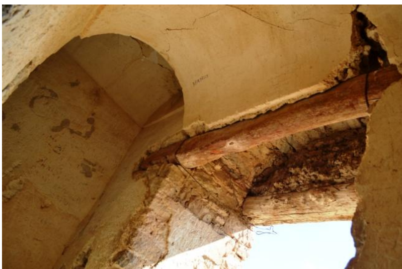
Voute en berceau, côté de la fenêtre carrée.
