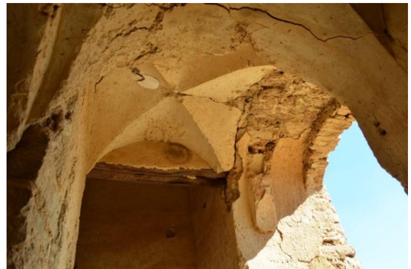
Voute d'arêtes, côté de fenêtre en arc plein cintre
