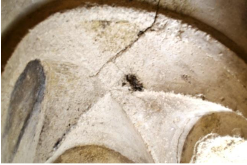
Voute d'arêtes à l'intérieur du minaret.
