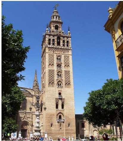
Fig.24 LA GIRALDA DE SEVILLE, 'ancien minaret de la grande mosquée almohade de Séville, en Andalousie.1172 Source : wikipédia
