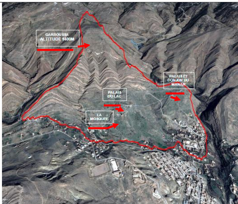
Fig.14 Image Satellitaire de la Kalaa Avec localisation de la mosquee par rapport aux composantes du site Source : PPMVSA De La Kalaa 3eme Phase
