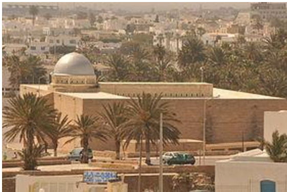
Fig.26 Vue générale de la Grande Mosquée de Mahdia, Source : wikipédia
