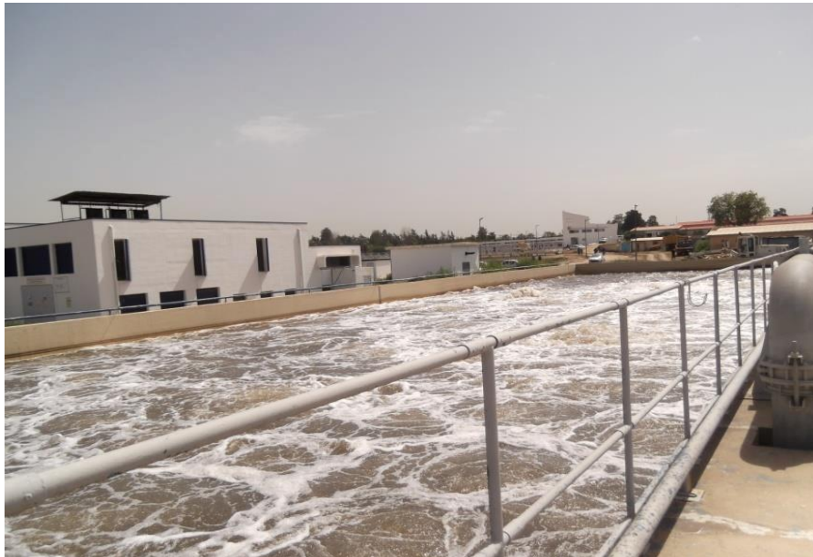
Figure II.08 : Bassins d'aération
