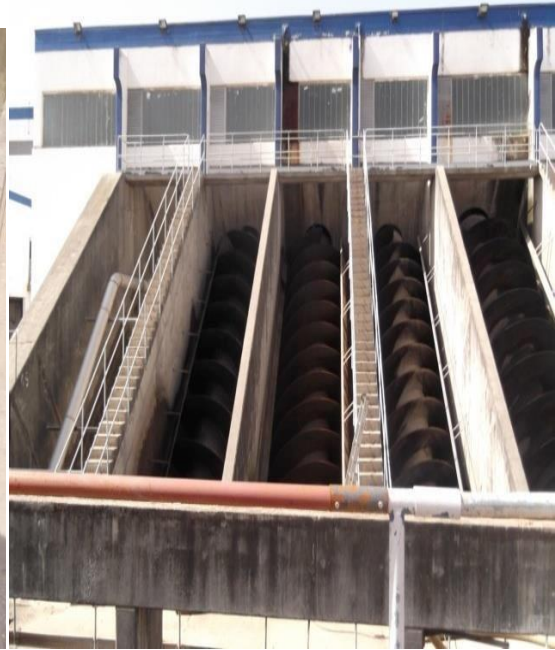
Figure II. 04: Vis d'Archimède.
