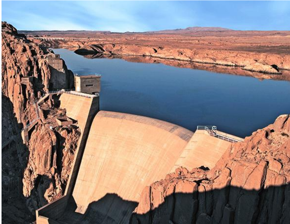
Figure 3-4 : Barrage de Brézina (ANBT)
