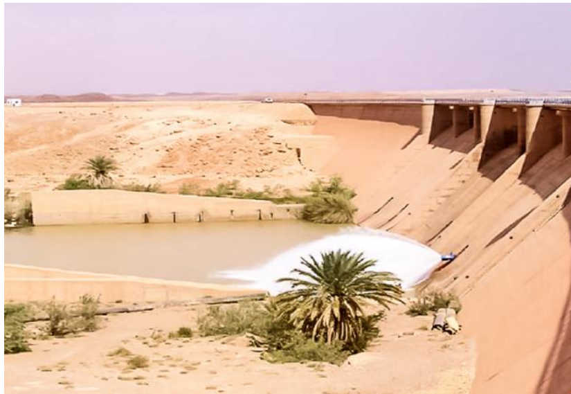
Figure 3-1 : Barrage de Djorf Torba (ANBT)
