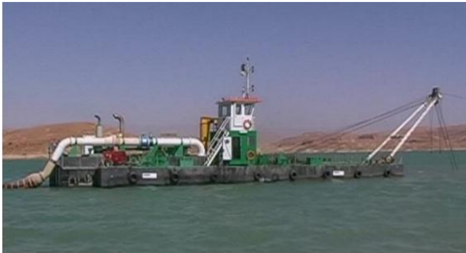
Figure 4-14 : La drague est au centre de la retenue du barrage de Foug El Gherza (cliché ANBT Biskra, 2006)
