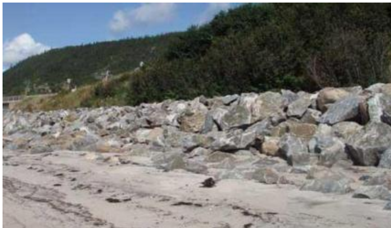
Figure 2-10 : Protection de falaise par enrochement. (Guèvremon)
