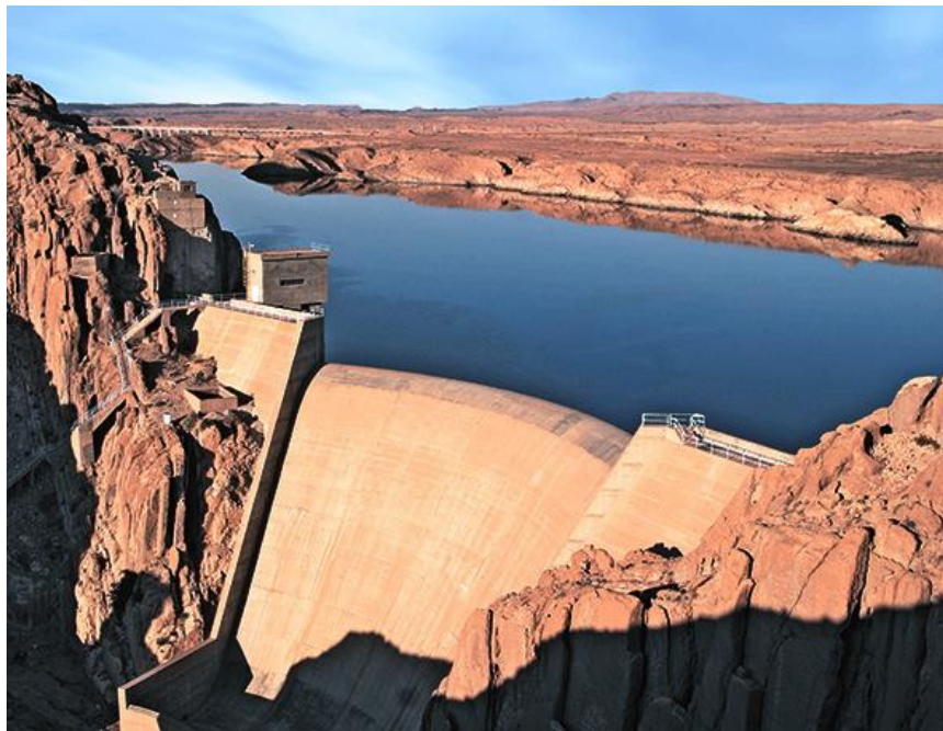
Figure 3-6 : Barrage de Brézina (ANBT)
