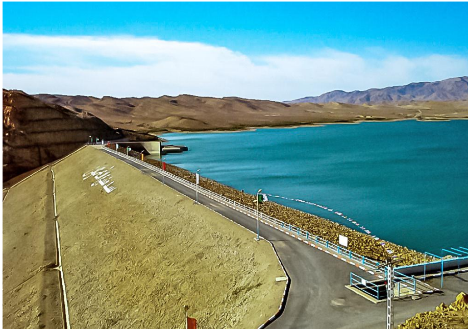
Figure 3-2 : Barrage de fontaine des gazelles (ANBT)
