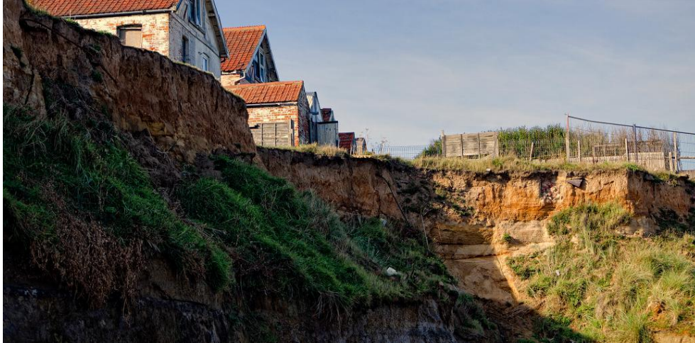
Figure 1-5 : Maisons inoccupées à cause de l'érosion de la falaise (COLIN, 2018)
