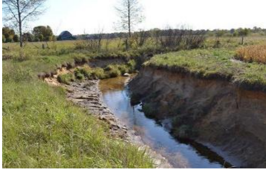
Figure 1-4 : Erosion des berges résulte du sapement et de l'affouillement des berges des cours d'eau naturels et des canaux de drainage. (RITTER, 2012)
