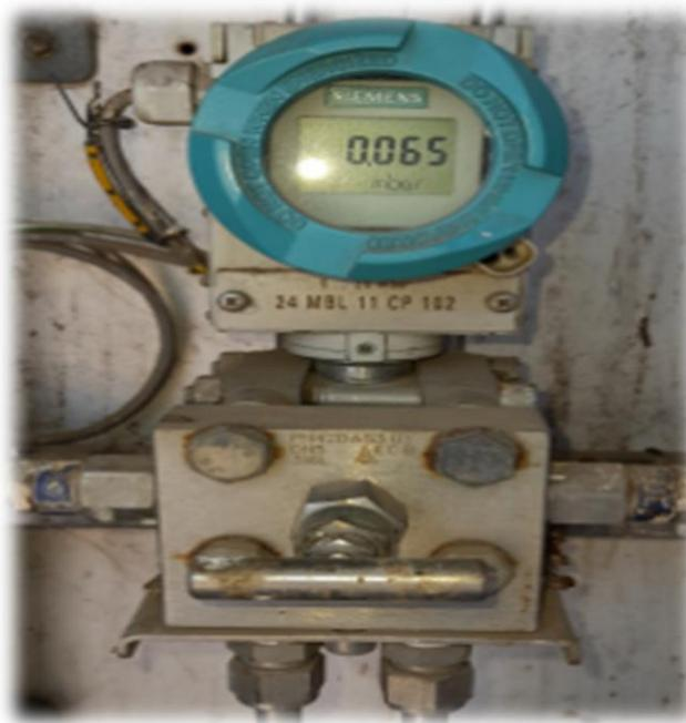
Figure II.32 : transmetteurs de pression différentielle
