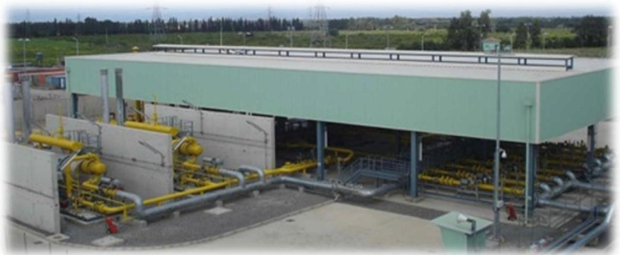
Figure I.15 : poste de distribution du gaz principal
