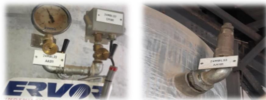
Figure II.15 : réservoir avec un manomètre, pressostat et une soupape
