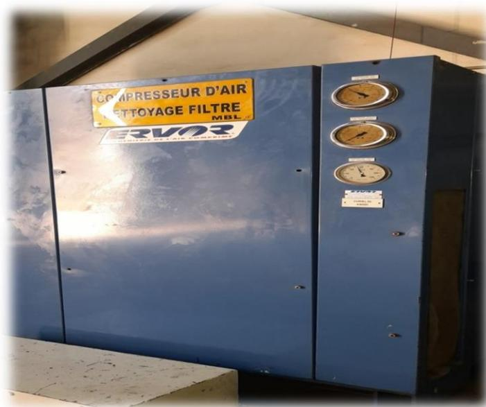
Figure II.4 : compresseur rotatif à vis **ERVOR**
