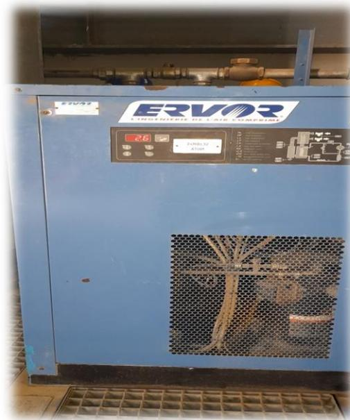
Figure II.12 : Sécheur d'air par réfrigération
