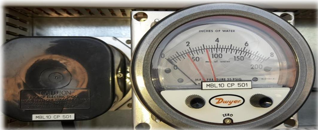
Figure II.26 : pressostat-indicateur de pression photohelic
