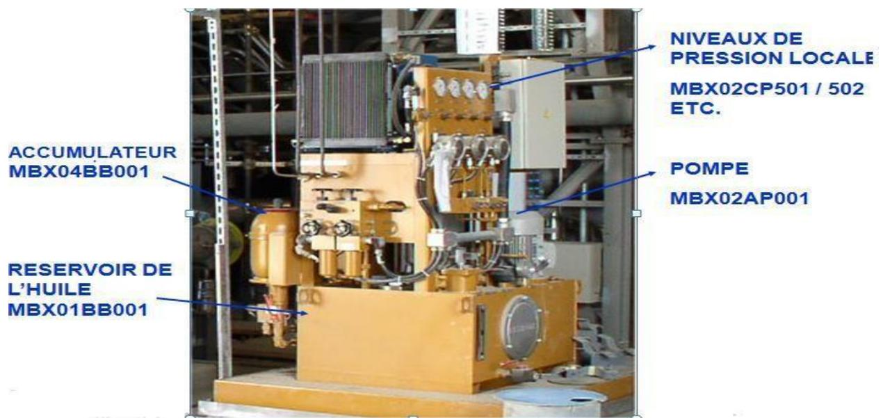
Figure I.19 : Système D'huile Hydraulique [6]
