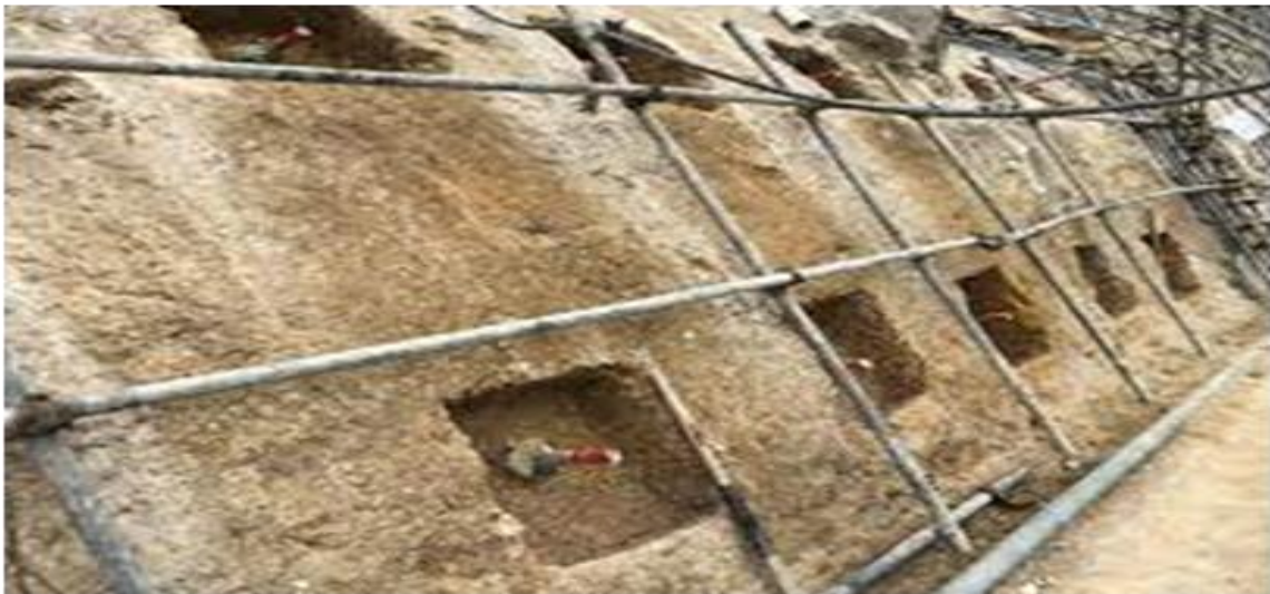
Figure 1.13 : Têtes de clous dans des niches [5]
