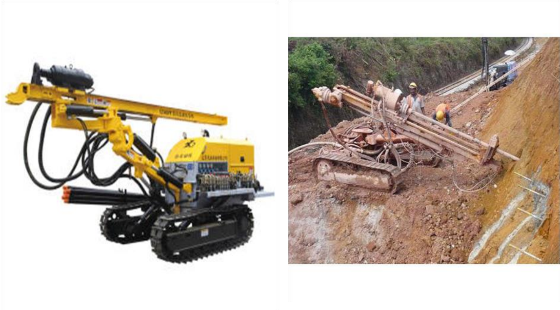
Figure 1.8 : foreuse pneumatique pour l'installation de clous
