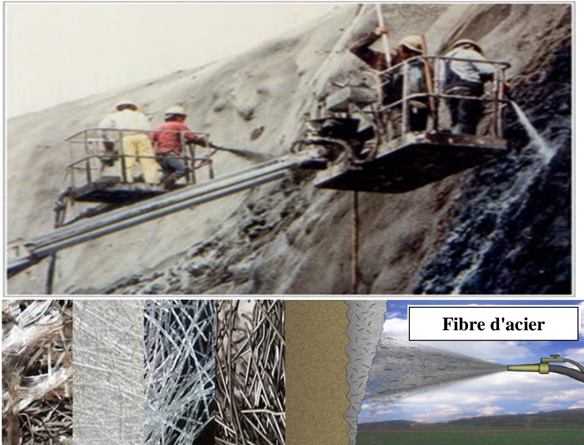
Figure 1.15 : application de béton projeté mélangé avec des fibres d'acier
