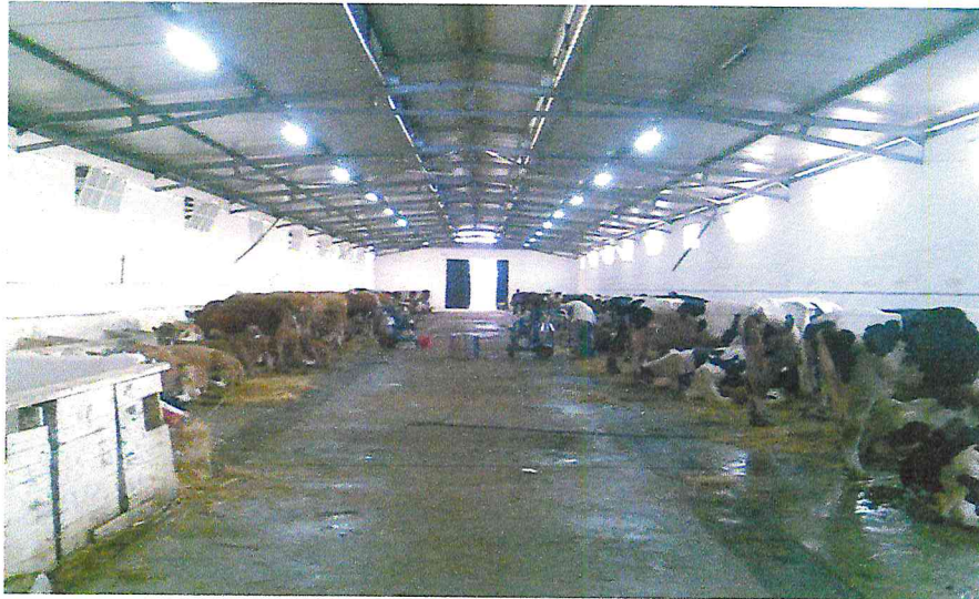
Figure 01 : La ferme vue de l'intérieur.
